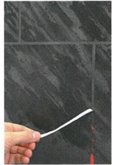
5 Klebebänder rechtzeitig entfernen
