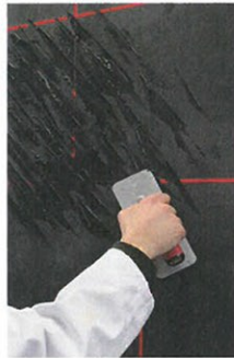
3 Batzen von etwa 1 cm Höhe und 10 cm Länge diagonal aufbringen
