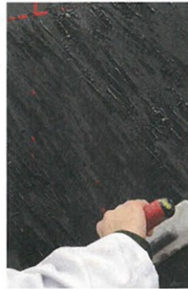
4 Im noch feuchten Zustand in gleiche Richtung leicht abglätten
