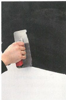
1 Vollflächiges Spachteln mit MagicTouch im Farbton 790-M
