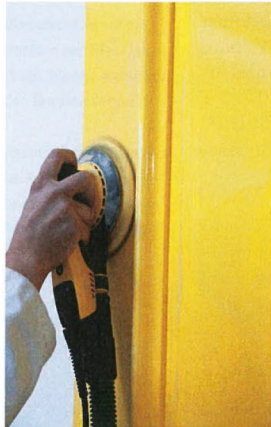
Zunächst muss der Untergrund vorbereitet werden, zum Beispiel durch Schleifen
